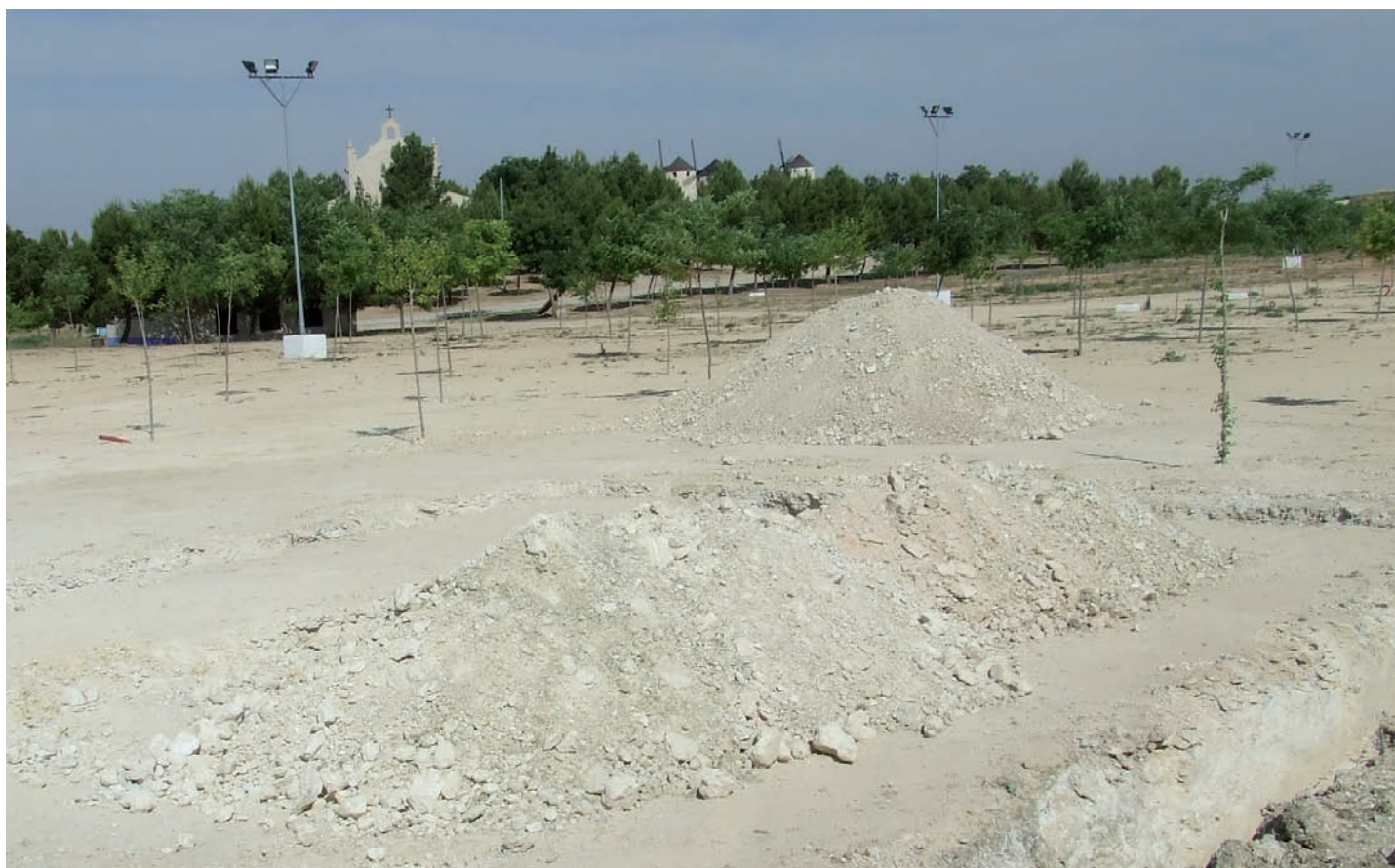
Estos días, comenzaban las obras para la construcción de unos aseos
