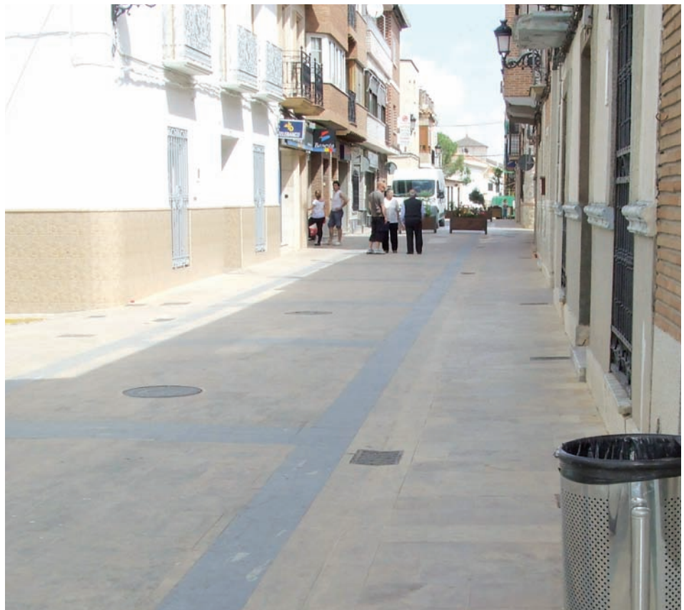
Resultado de la primera fase de las obras
