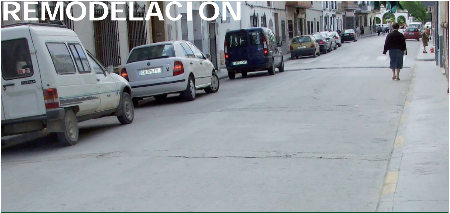
Estado actual de la calle
