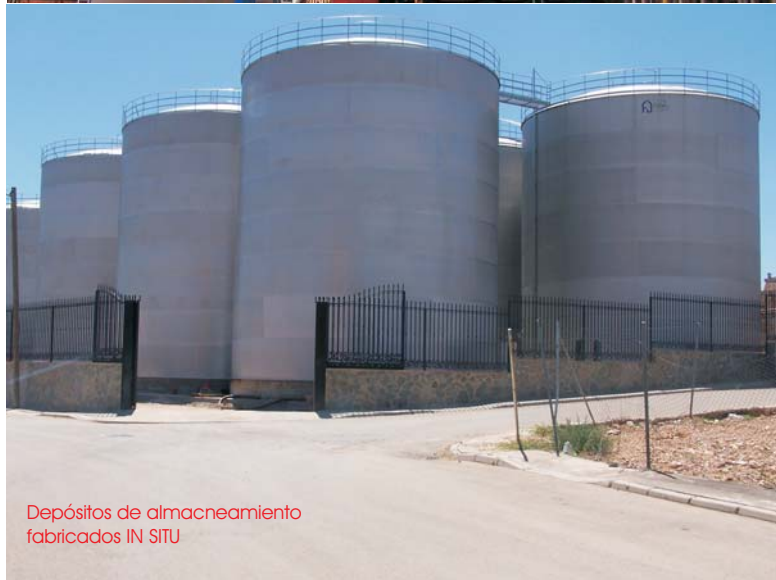
Batería de depósitos montados en obra
