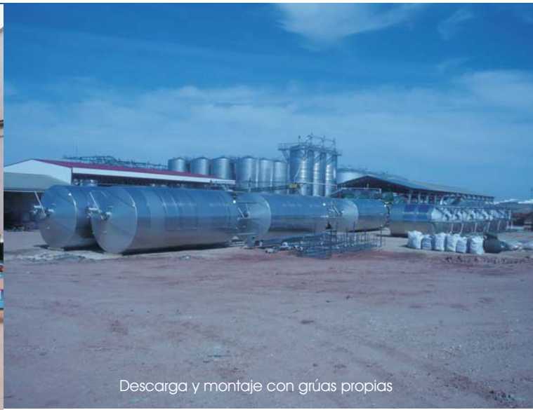
Depósitos para fermentación con camisas de refrigeración
