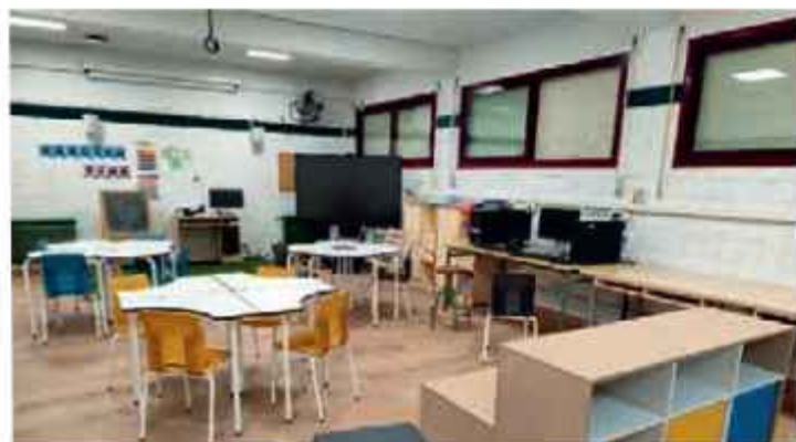
Climatización del CEIP Cervantes, en el edificio de primaria.
