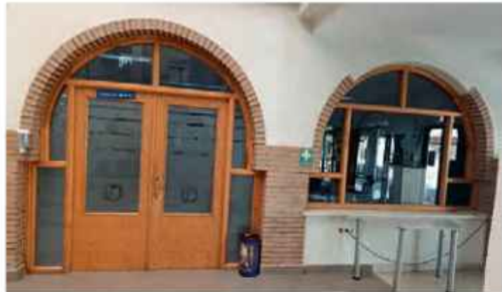
Instalación de nueva cubierta en el Centro Multi funcional.
